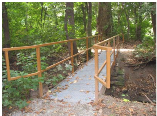
Die erneuerte Brücke
