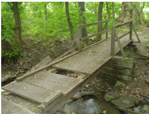
Die Brücke vor der Erneuerung
